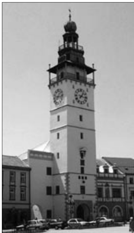
Zajištění stability radniční věže ve Vyškově kabely. Rozšíření základů věže pomocí předpínání (nová reverzní klenba a základové konzoly)
